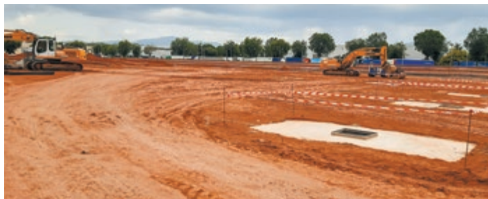
► La parcela de 34.000 m 2 al Pol. Ind. Riera de Caldes on Fedefarma ha començat les obres del seu nou centre logístic.
