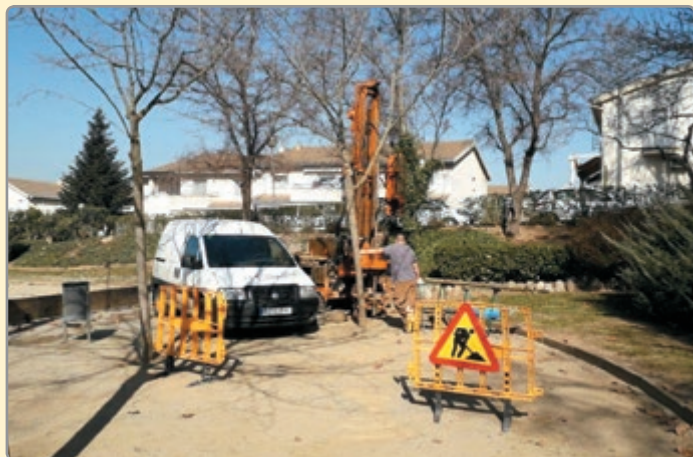
• Presa de mostres del sòl per a l'estudi geotècnic.
