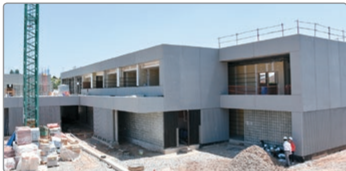
• Estat actual de les obres d'ampliació del Can Periquet.
