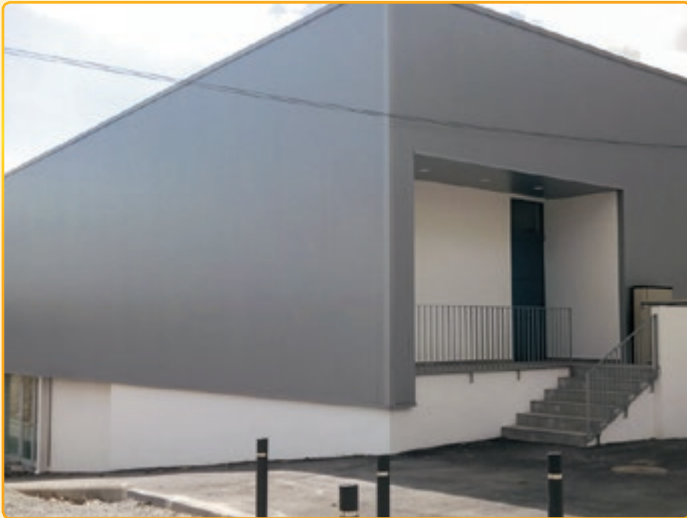
• Part frontal de les noves instal·lacions.
