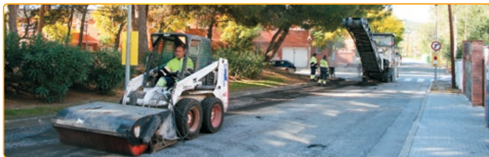
• Inici de l'asfaltat a Can Maiol.
