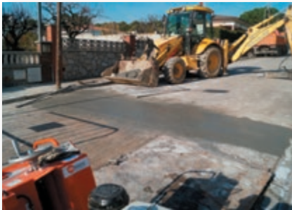
C/ Gaig (Can Falguera) Millora paviment
