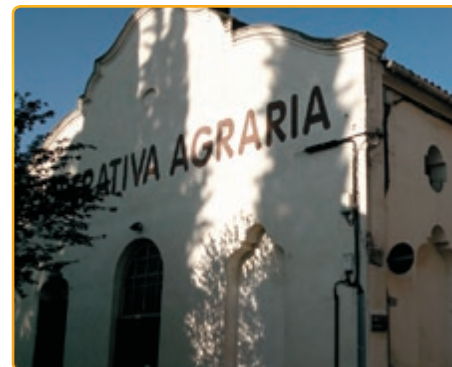
• Instal·lacions actuals del sindicat o cooperativa.
