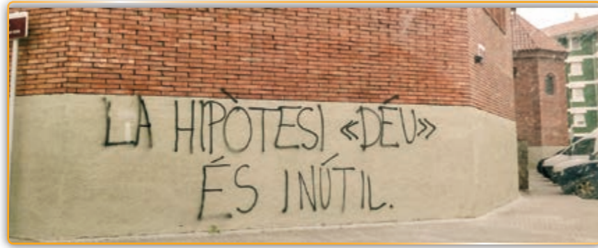
• Estat actual de la façana de Sant Genís.
