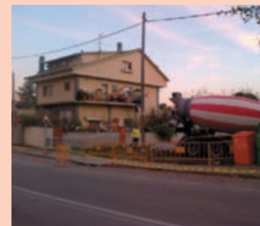
Barri Can Falguera Reparació del clavegueram al C/Major amb Torrent del Caganell
