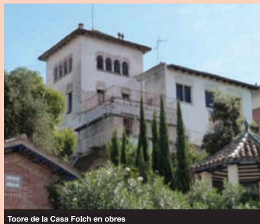
Toire de la Casa Folch en obres
