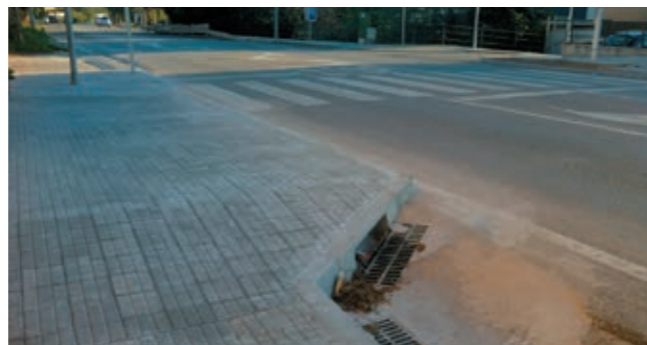
Arranjament del pas de vianants de l'Av. Catalunya a l'altura de la Tenda Nova
