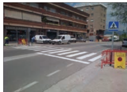
Nou pas de vianants a l'Av Catalunya a l'altura de la Pedra Llarga
