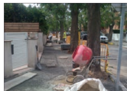
Arranjament de voreres al C/ Flequers, al barri de la Plana de Can Maiol
