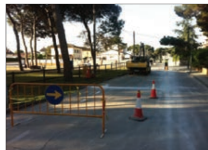
Asfaltats al barri de la Pineda-Sud
