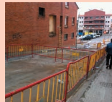
Carrer Riereta Nova vorera, ordenació del trànsit i millora del clavagueram i il·luminació
