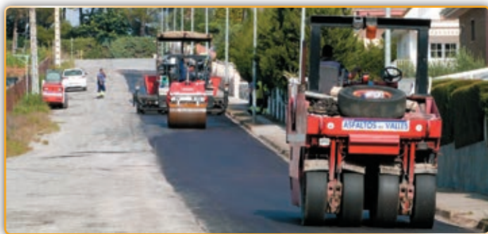
• Treballs d'asfaltament del carrers a Can Duran.
