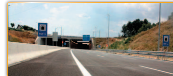
• Tram del Quart Cinturó entre Terrassa i Viladecavalls, al Vallès Occidental..
