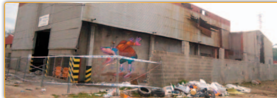
• Estat actual de la nau de l'antiga Trefal.
