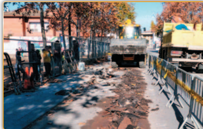
• Obres de l'ampliació de la vorera a Folch i Torres.
